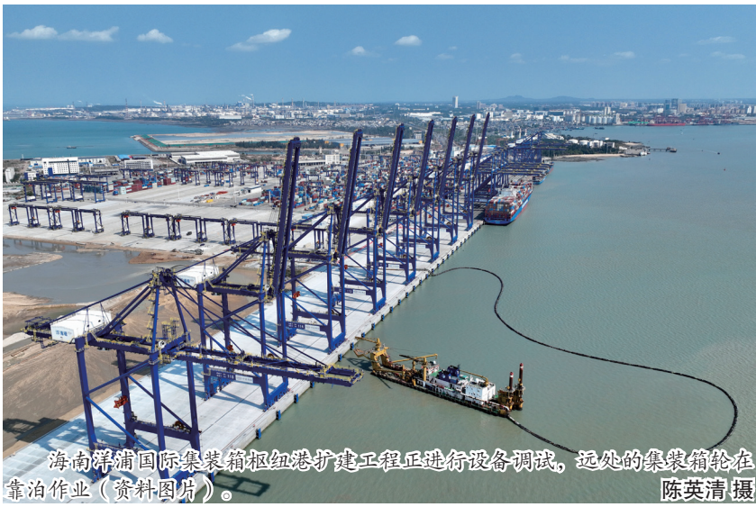
海南洋浦国际集装箱枢纽港扩建工程正进行设备调试，远处的集装箱轮在靠泊作业（资料图片）。陈英清摄 工程经理郭骏说，八所港是中国面向共建“一带一路”国家最近的港口之一，企业在此建设再制造产业项目，有利于借助自贸港政策和区位优势，打造面向国际市场的工程机械维修与再制造中心。
